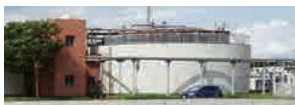
更新予定の中央浄化センター消化槽
