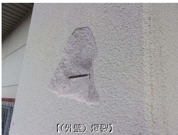
【(外壁) モルタル剥落】
