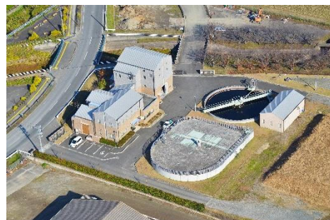
▲ 田主丸浄化センター
