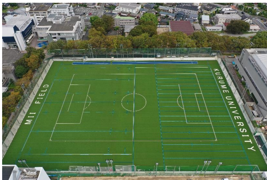
図 3-6-2 久留米大学雨水貯留施設
