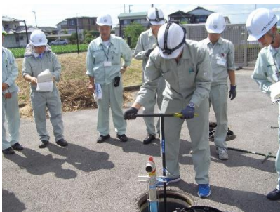
▲職員による現場研修の様子
