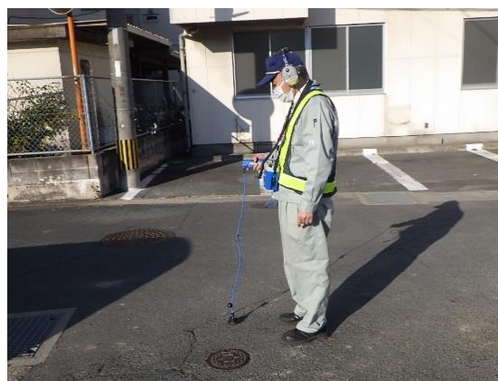
▲ 漏水調査の様子
