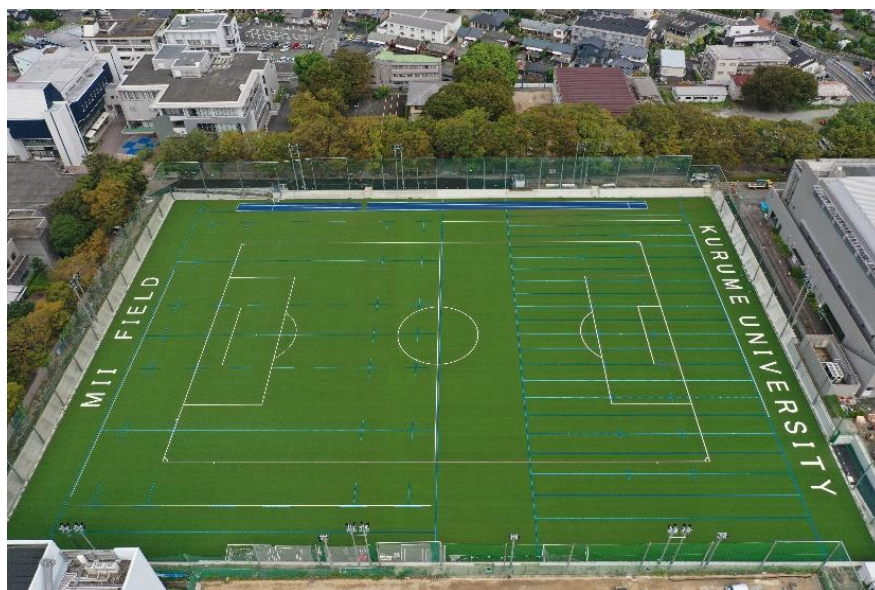
図 3-6-2 久留米大学雨水貯留施設
