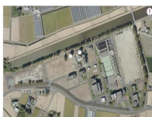
南部浄化センター
