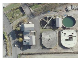
田主丸浄化センター
