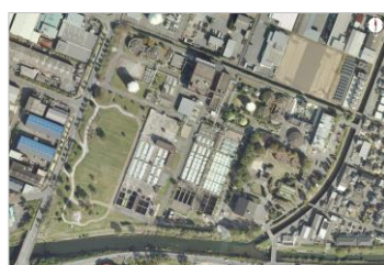
中央浄化センター
