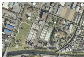
中央浄化センター
