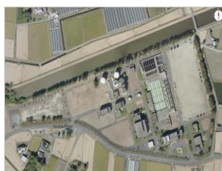
南部浄化センター
