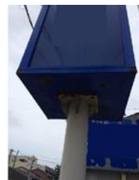
支柱・広告板接合部
