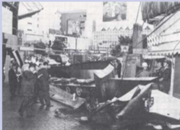
台風で落下した時の様子
