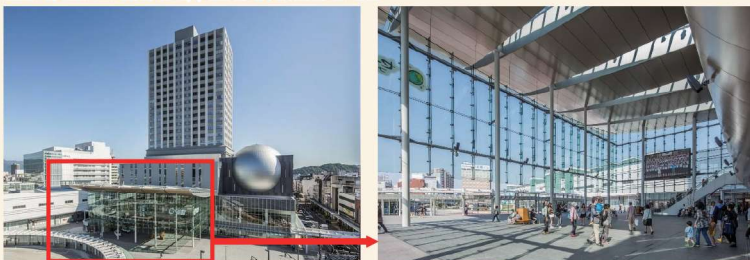
▲複数の都市機能が集積したJR福井駅の再開発ビルと併設された屋根付き屋外広場
