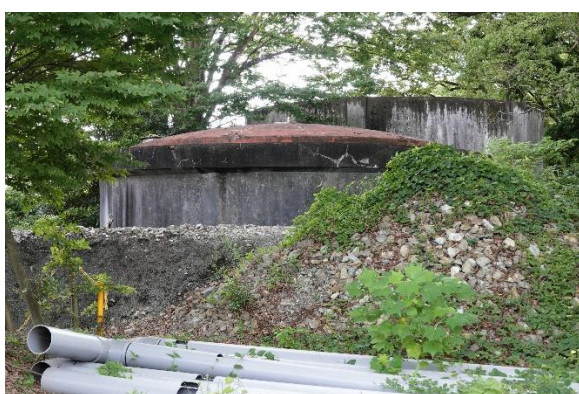
【建設物2】ガスタンク
