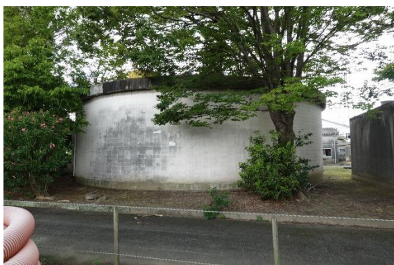
【建設物1】第2消化槽
