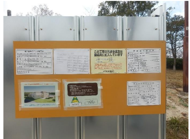
写真 3 : 外部仮囲い掲示状況
