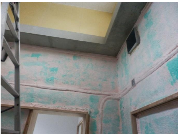
写真 6 : 内部工事状況
