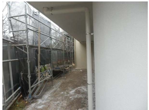
写真 5 : 外部足場状況
