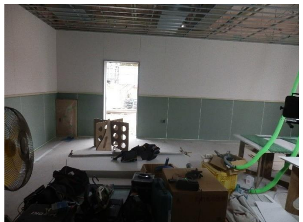
写真 7 : 内部工事状況
