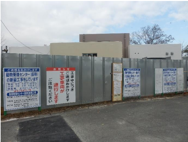
写真 2 : 外部仮囲い掲示状況
