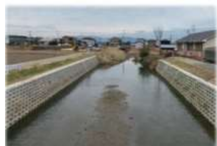
排水機能が強化された安武川
