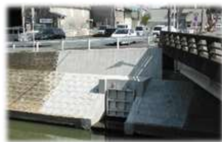
フラップゲートが整備された下弓削川
