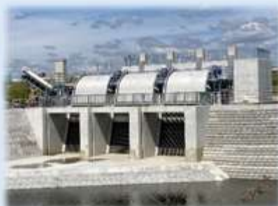
枝光上流排水機場
