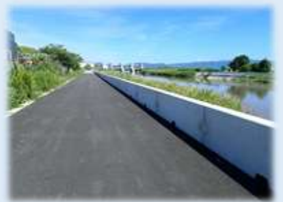
河川護岸嵩上げ（山ノ井川）
