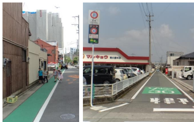
通学路や学校周辺における生活道路にカラー舗装やゾーン30などの交通安全対策を実施(学校周辺安全対策事業)
