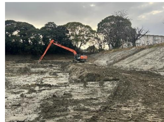
ため池の浚渫
