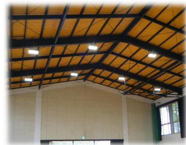
LED照明に改修した体育館
