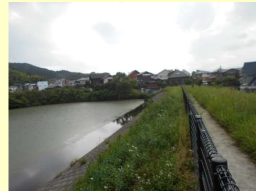
防災重点農業用ため池
