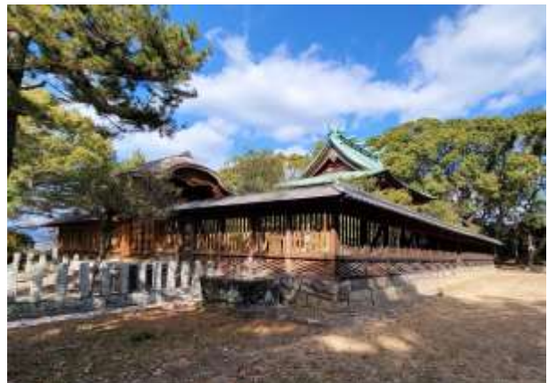
透塀 (南東から)
