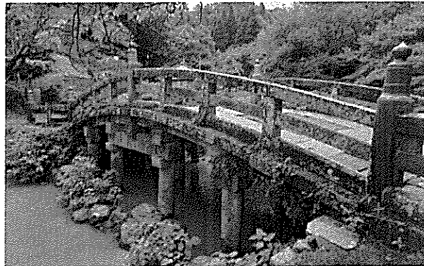
高良山御手洗橋
