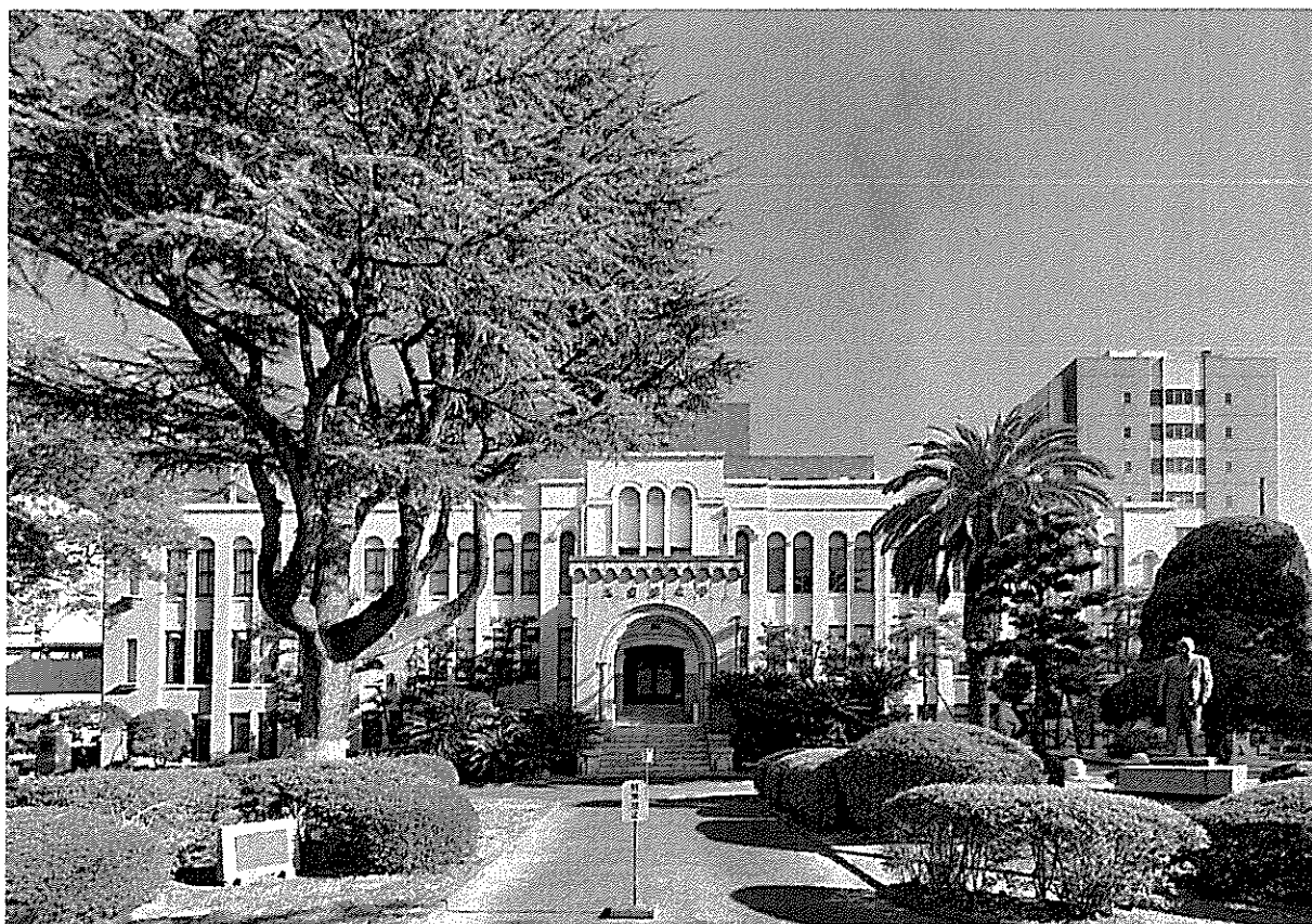
久留米大学本館（西から）
