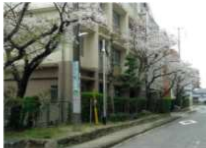
地域における街頭防犯カメラの設置 ※小学生への声掛け事案発生箇所への設置
