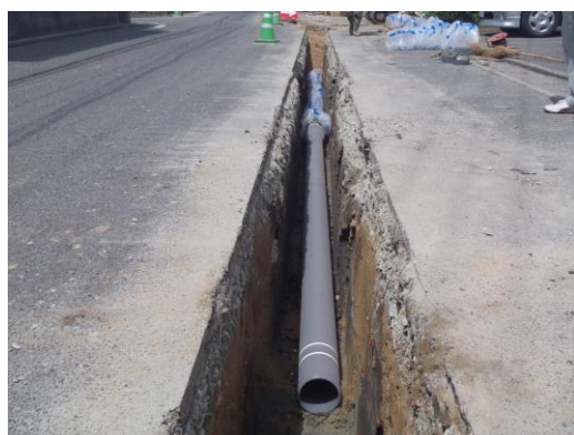
耐震性のある水道管へ更新
