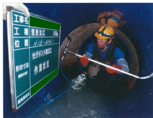
下水道管の内面更生
