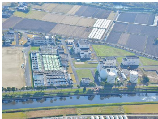
南部浄化センター（安武町）
