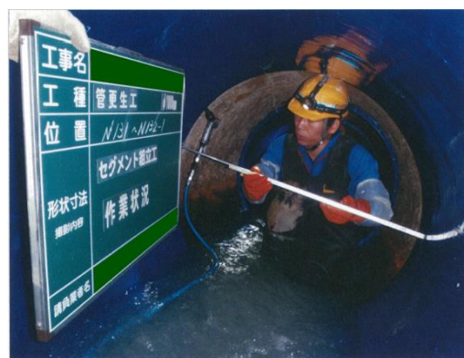
下水道管の内面更生
