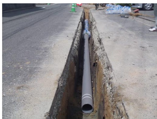
耐震性のある水道管へ更新
