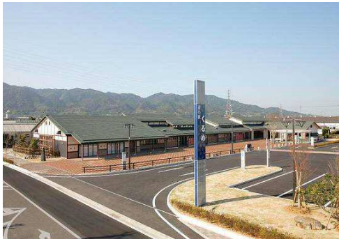
複合アグリビジネス拠点施設 (道の駅くるめ)
