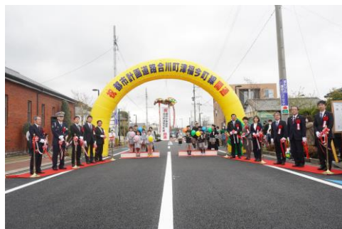
中環状道路が全線開通
