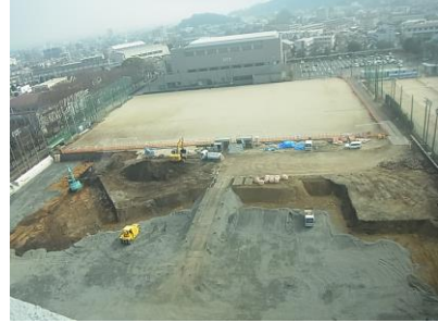
雨水貯留施設工事の状況（久留米大学グラウンド）
