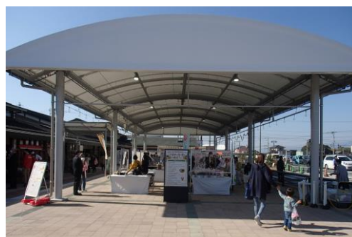
落成した道の駅くるめの大型屋根
