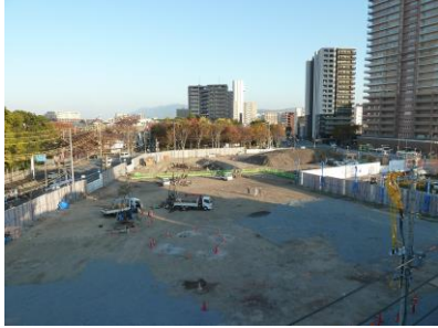
解体が完了した JR 久留米駅前第二街区
