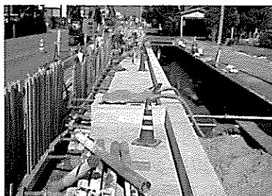
●歩道設置整備
