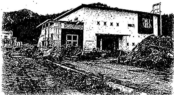
「鵜住居地区防災センター」これまでの防災対策が十分に機能していなかったことを浮き彫りにした。
