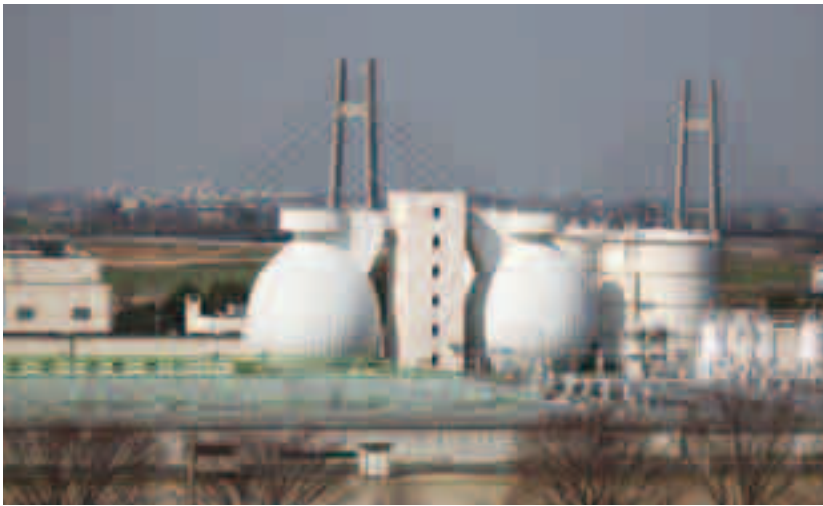
三瀧・城島地域の汚水処理を行う予定の南部浄化センター
