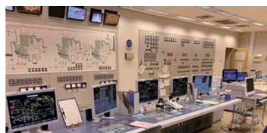
電算制御システムの一例
