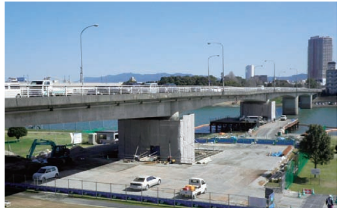
耐震化工事が進む長門石橋
