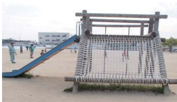
老朽化したロープネットを取りかえた遊具
