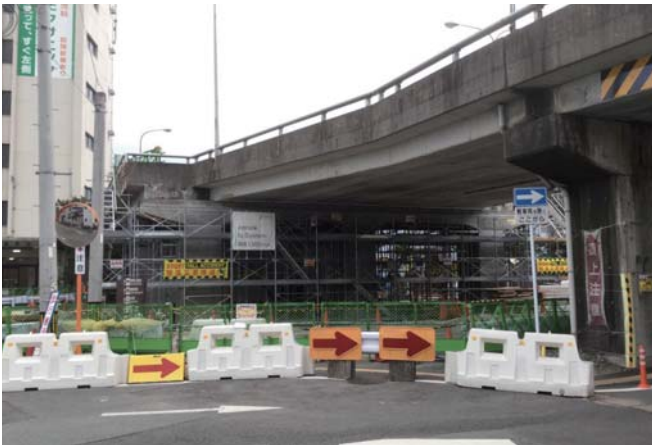
耐震補強工事を行っている長門石橋取付高架橋
