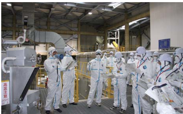
宮ノ陣クリーンセンターのボイラを調査
