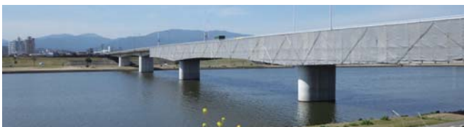
耐震補強工事をしている長門石橋
