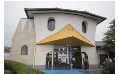
平成29年度に改修予定の 田主丸ふるさと会館
