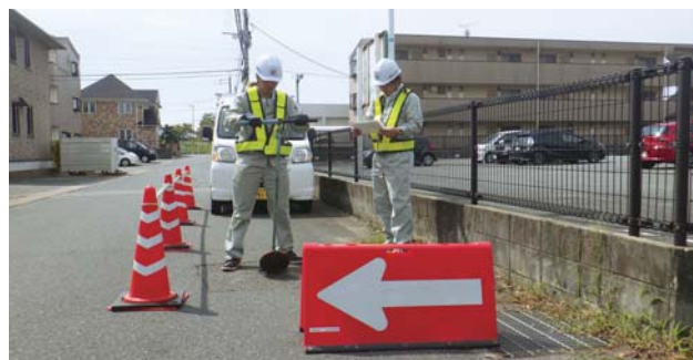
漏水箇所の断水のため作業を行う職員
