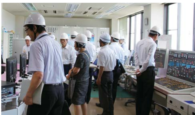
下水処理設備の制御や監視を行う中央監視室
