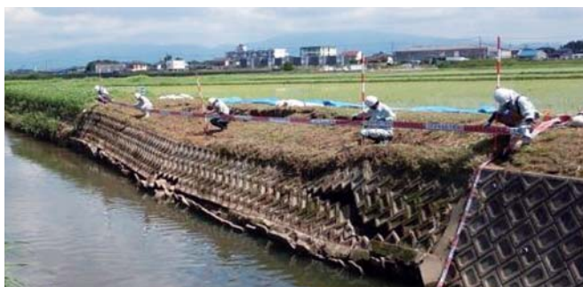
大雨により被害を受けた野添川の護岸
