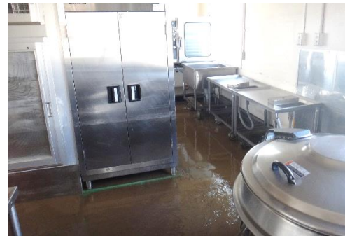
浸水した給食室
