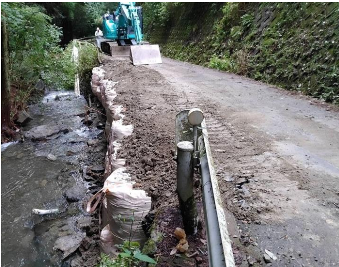
道路(高良内町)の修繕
