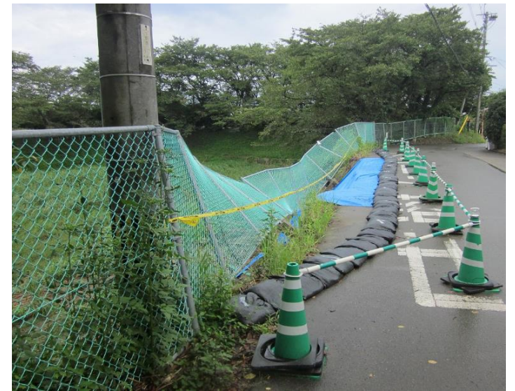
ため池(山本町)の修繕
