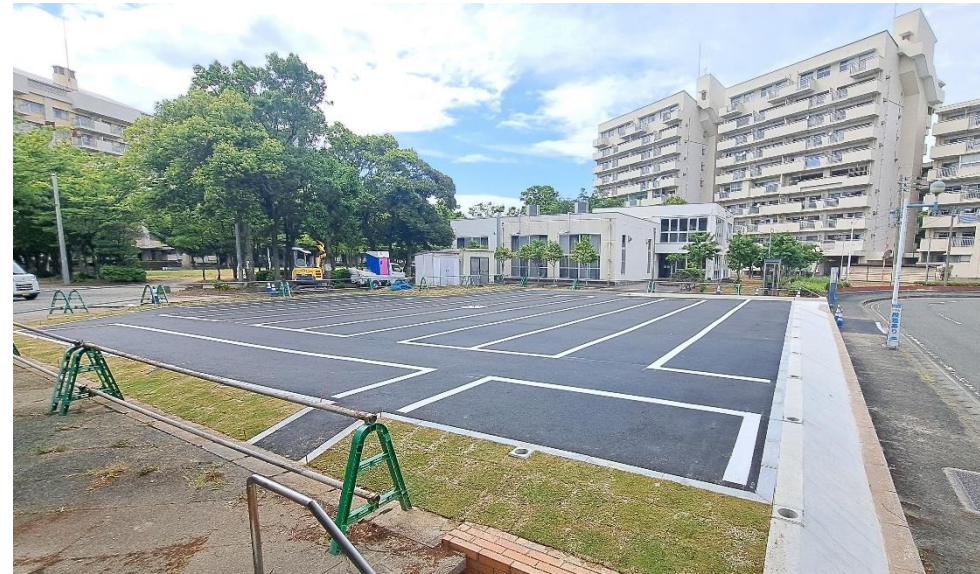
整備場所 (工事中)
