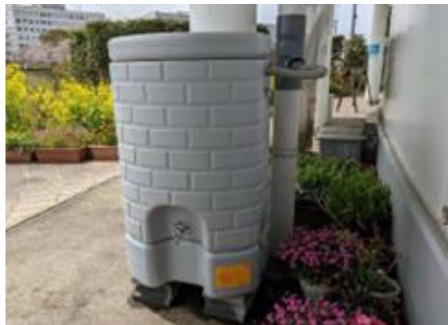
雨水貯留タンク設置事例
