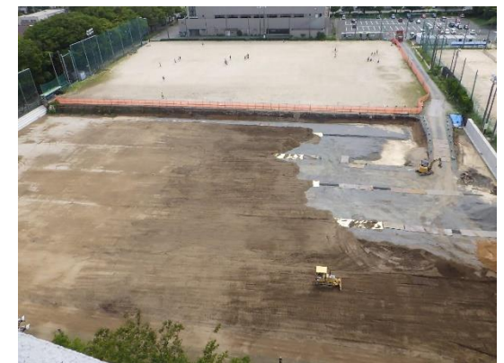
施工中の久留米大学貯留施設
