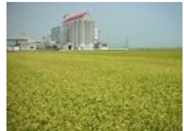
米麦等の感想調整施設（カントリーエレベーター）
