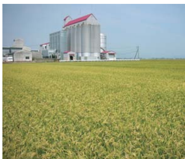
【米麦等の乾燥調整施設(カントリーエレベータ)】
