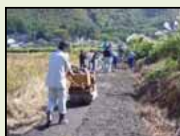
未舗装農道の舗装
