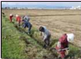
水路の泥上げ
