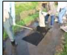
農道の部分補修
