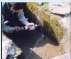
ひび割れの補修
