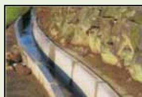
素堀り水路からの更新
