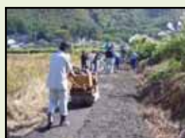
未舗装農道の舗装
