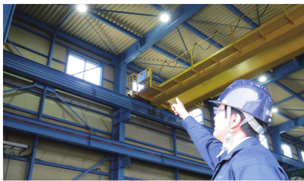
改修したLED照明
