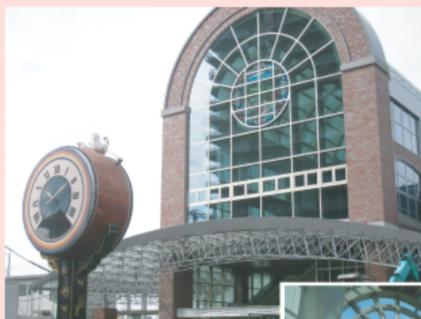
JR久留米駅 新幹線駅舎東口外観と西口内観
