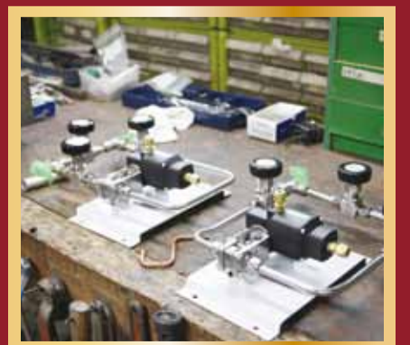
特殊金属や様々な分析配管を溶接。
