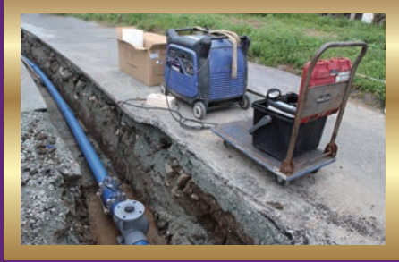
融着機で配管を接続する様子
