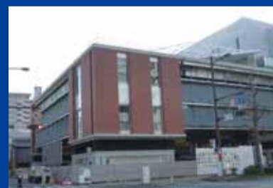
現在建設中の久留米シティプラザにも手嶋さんの技術が活かされています。
