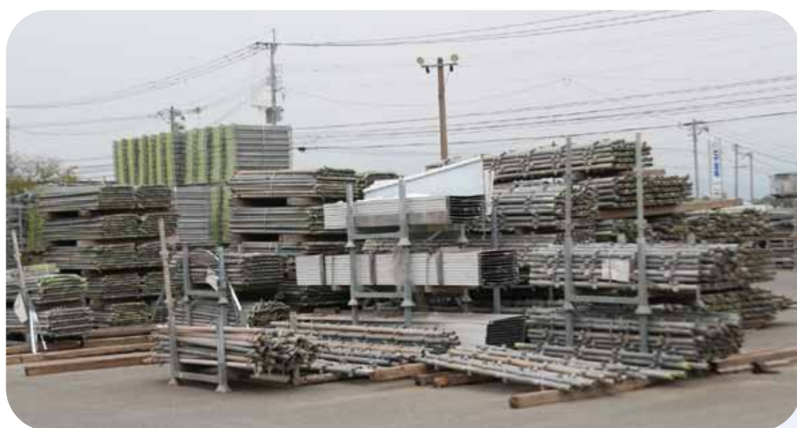
◀久留米市北野町にある資材センター 仮設足場の洗浄などを行う
