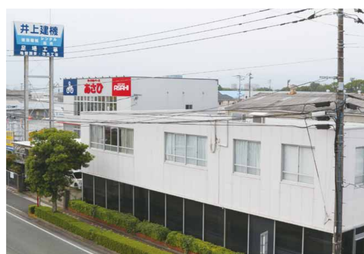
▲株式会社井上建機リース外観
